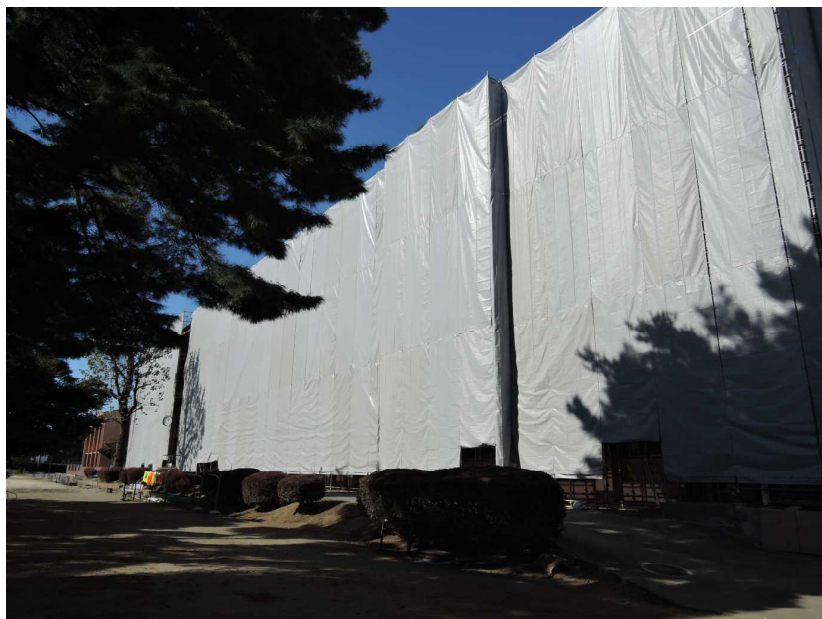
塗装工事中の本館
